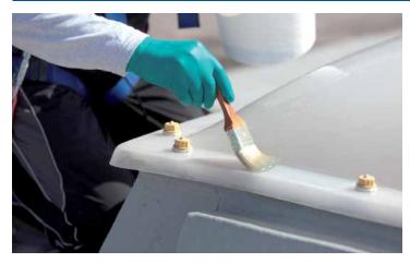
Rivestite altresì la superficie soprastante il telaio/bordo del lucernaio con KEMPEROL® FALLSTOP. Usate indifferentemente il rullo di perlon o il pennello per questo lavoro. Evitate che il prodotto che state lavorando coli oltre il bordo o il tetelaio del lucernaio.
