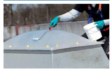
KEMPEROL<sup>®</sup> FALLSTOP può essere sovra verniciato dopo circa 4 ore. Ripetere altre 3 volte le lavorazioni di rivestimento descritte. Ogni volta ricordatevi di fare attenzione alle fasi da 1 a 5.
