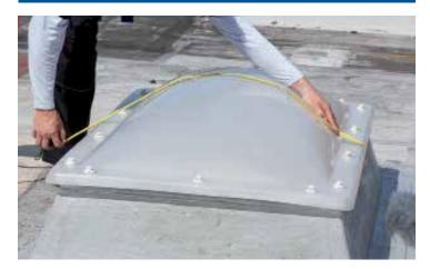
La quantità necessaria di materiale deve essere calcolata prima di iniziare il rivestimento del lucernaio. Questa misura include il rilevamento dell'intera area del lucernaio, considerando la curvatura della superficie.
