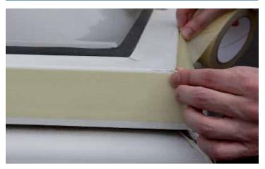
Durante la posa di KEMPERTEC<sup>\*</sup> FALLSTOP su lucernai dotati di telaio, ricordatevi di rivestire completamente pure la superficie del telaio. Rivestite la superficie del telaio con attenzione, utilizzando un nastro adesivo al fine di assicurare una adeguata protezione.
