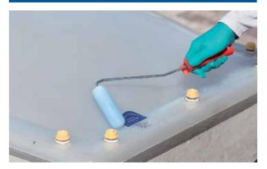
L'etichetta KEMPEROL° FALLSTOP evidenzia un numero seriale. Questa etichetta deve essere compilata con un pennarello resistente ai solventi e incollata sul terzo strato asciutto di KEMPEROL° FALLSTOP. L'etichetta verrà anche rivestita e protetta durante la quarta ed ultima fase di rivestimento con KEMPEROL° FALLSTOP.
