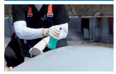
Dopo la pulizia preliminare, procedete con una pulizia accurata usando un panno che non perda lanuggine e KEMPERTEC\* FALLSTOP Cleaner, che evapora in 15 minuti: si raccomanda quindi di non applicare KEMPERTEC\* FALLSTOP prima che il Cleaner sia evaporato.
