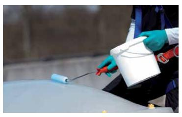
Versate gradualmente la quantità di prodotto che avete precedentemente preparato direttamente sulla superficie del lucernaio o applicatela in alternativa con il rullo di perlon. Impiegate il rullo di perlon per distribuire il prodotto sulla superficie, assicurandovi di effettuare una posa incrociata del prodotto liquido.
